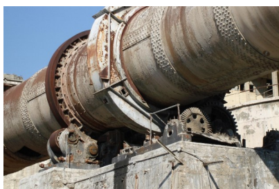
Ventilateurs de four, refroidisseurs de clinker ...
