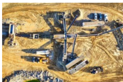
Déshydratation, alimentation en eau brute, ...
